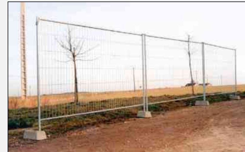
Figure 108 : Exemple de palissade de protection de chantier (source www.signals.fr )
